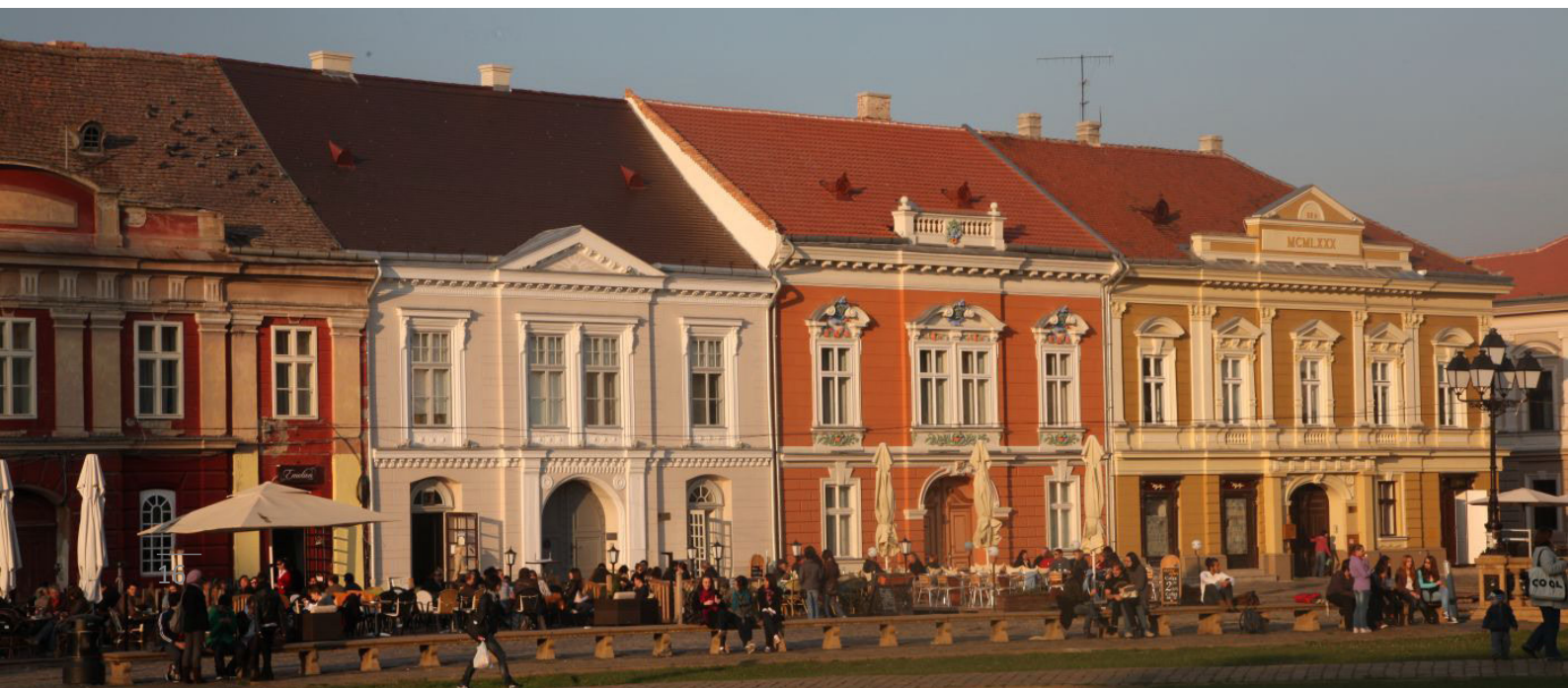
Fig. 2: Frontul de nord al Pieței Unirii cu imobile reabilitate și cafenele.
